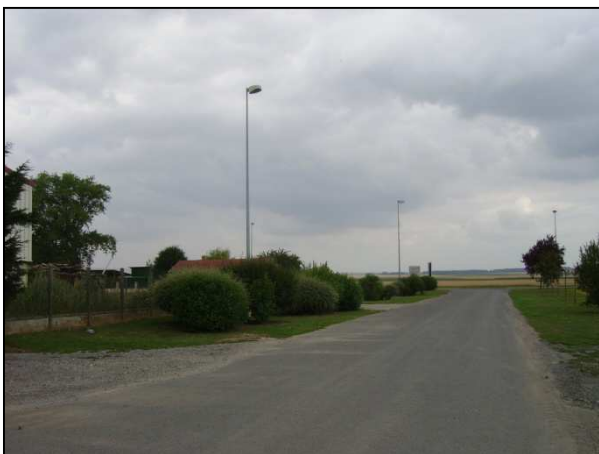
Vue extérieure entrée parcelle 117
